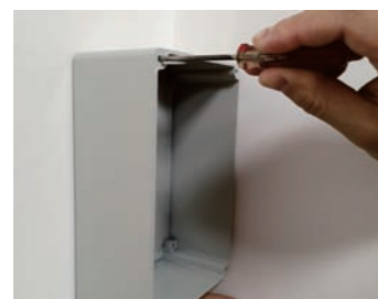
通过盒体的通孔用螺丝直接固定
